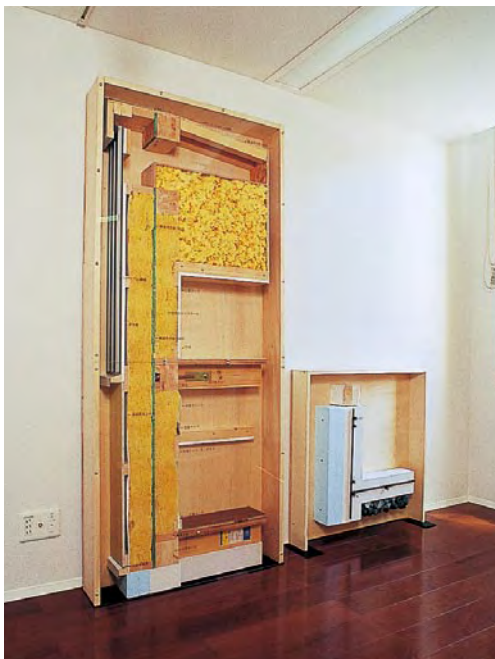
写真12 断熱工法模型
